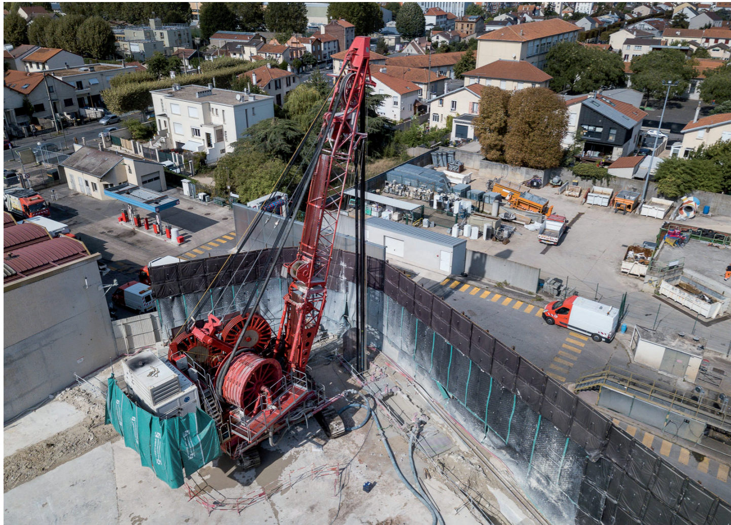
Fin de la paroi moulée sur le 1401 P
