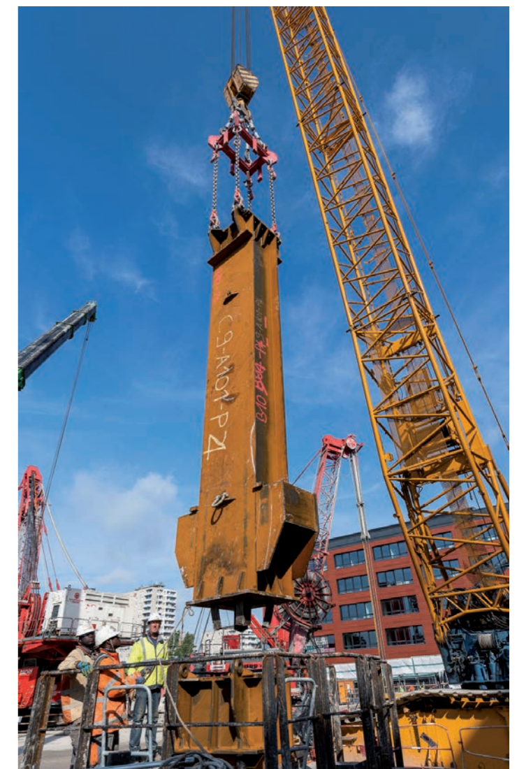
Mise en place des poteaux préfondés sur VDM
