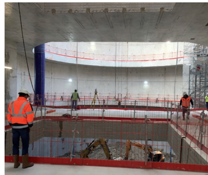
Fin du terrassement sur le 1302 P
