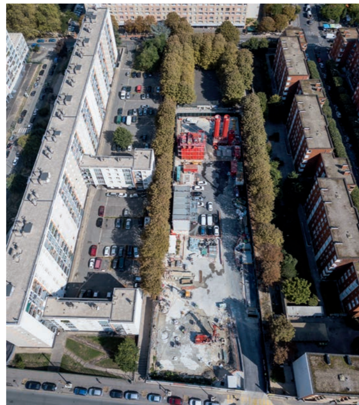
Premier ouvrage annexe : 1402
