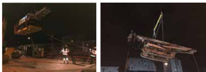
• Grutage des foreuses
