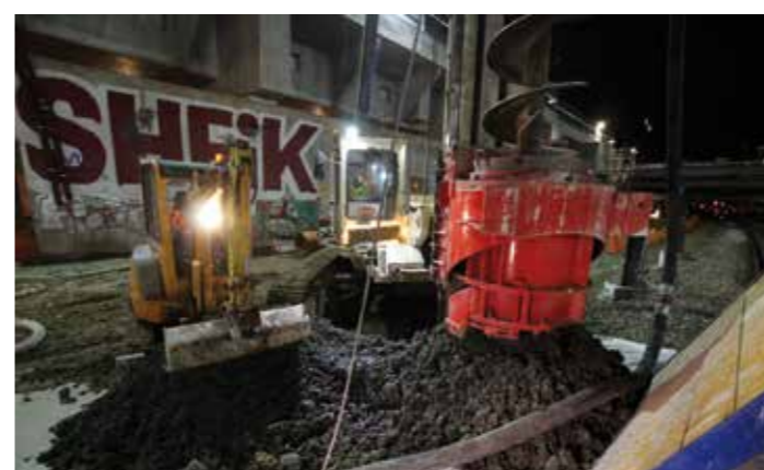
• Forage du pieu avec la Llamada P90
