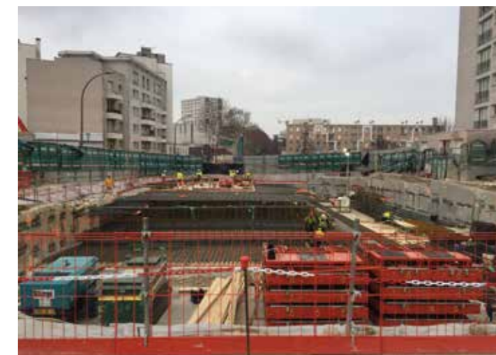
• Gare d'Issy - réalisation de la dalle de couverture.
