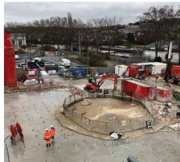
• OA P12 Réalisation des forages d'injection du rameau entre le puits de ventilation et le tunnel
