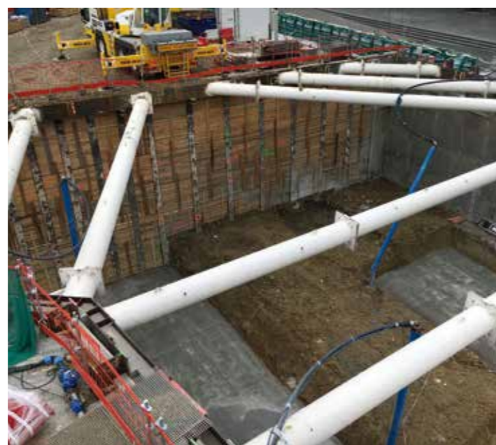
• Couloir de correspondance entre la ligne de métro n°9 et la gare de Pont de Sèvres
