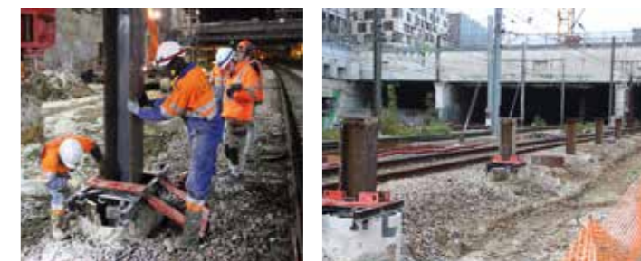
• Mise en place du guide et du profilé
