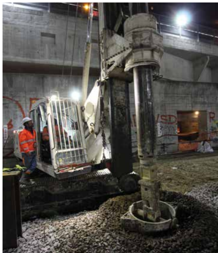
• Mise en place d'une virole par louvoyage avec la Mait 130
