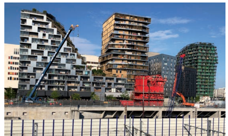
Vue de la plateforme haute (Avenue de France)
