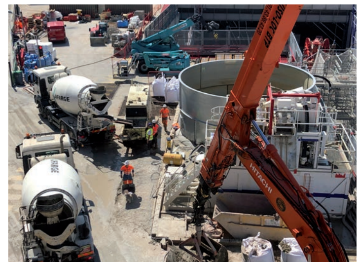
Bétonnage en cours
