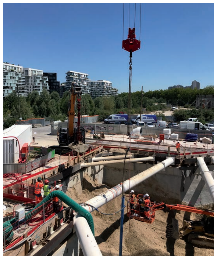
Ouvrage annexe P12
