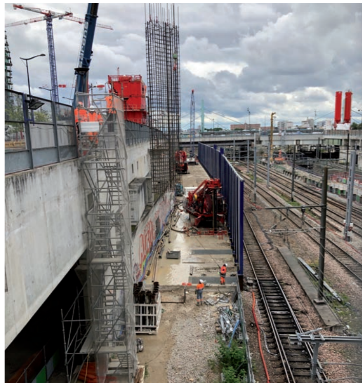
Équipement d'une barrette depuis la plate-forme haute
