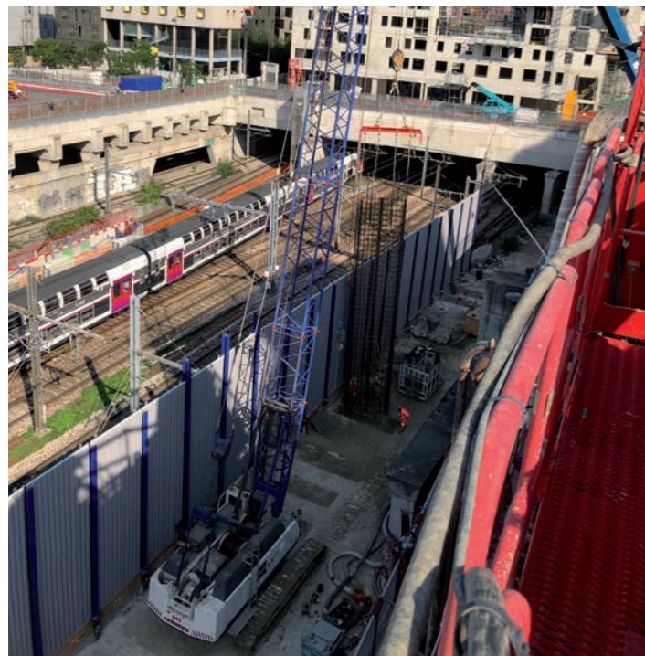
Équipement d'une barrette depuis la plate-forme basse
