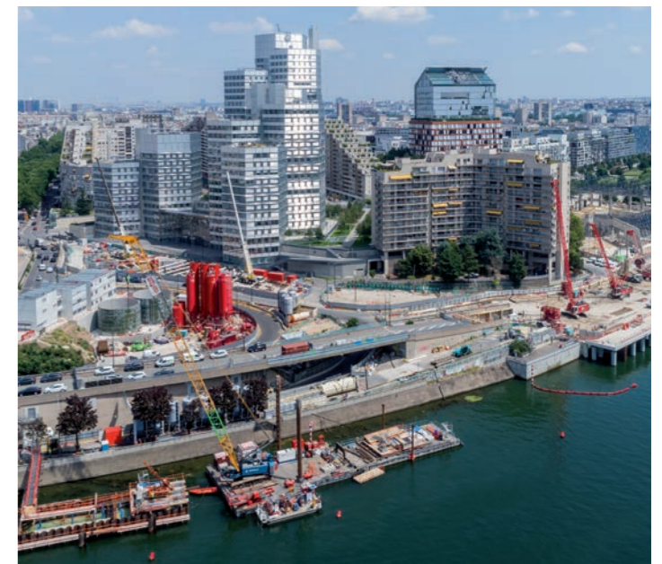
Pont de Sèvres
