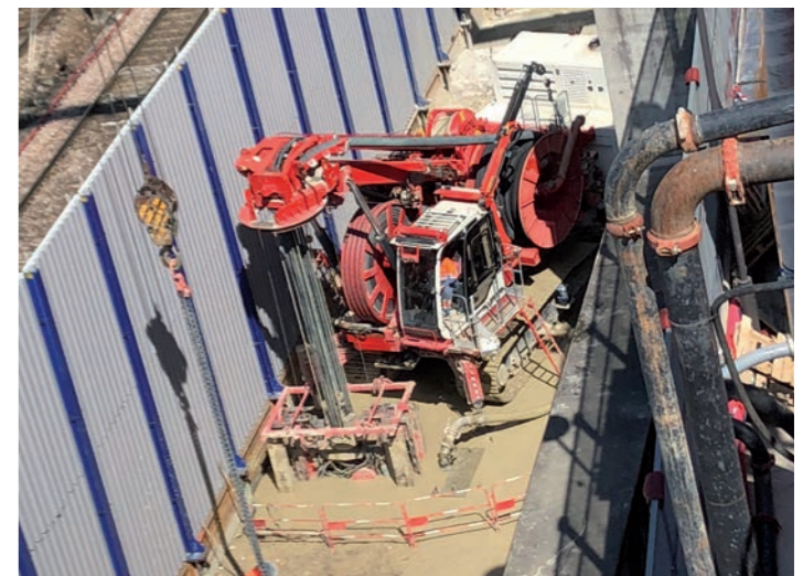
Excavation des barrettes courtes avec la HC05
