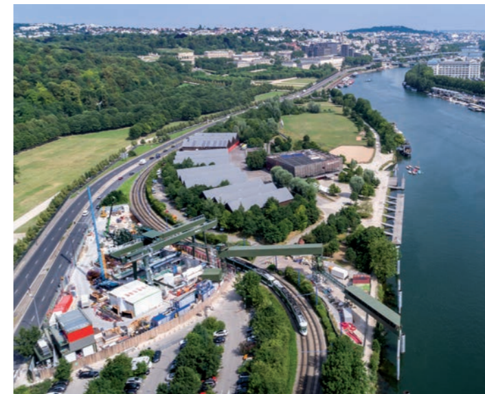
OAP13 - Puits de lancement Ile de Monsieur
