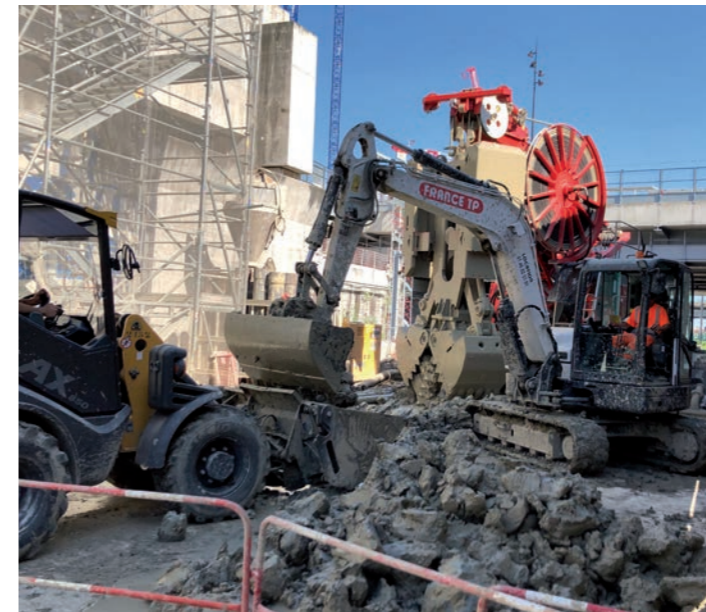
Excavation des Fausse Glaises par le KS court
