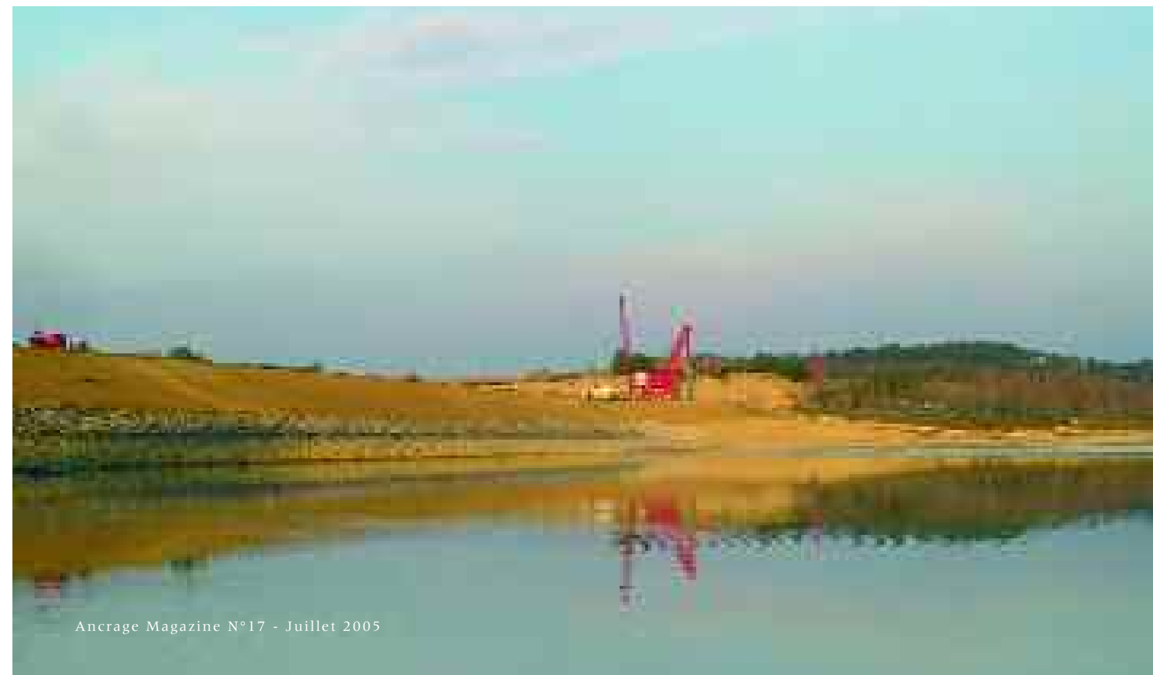
L'hydrofraise Evolution 3 sur la rive droite du barrage.
