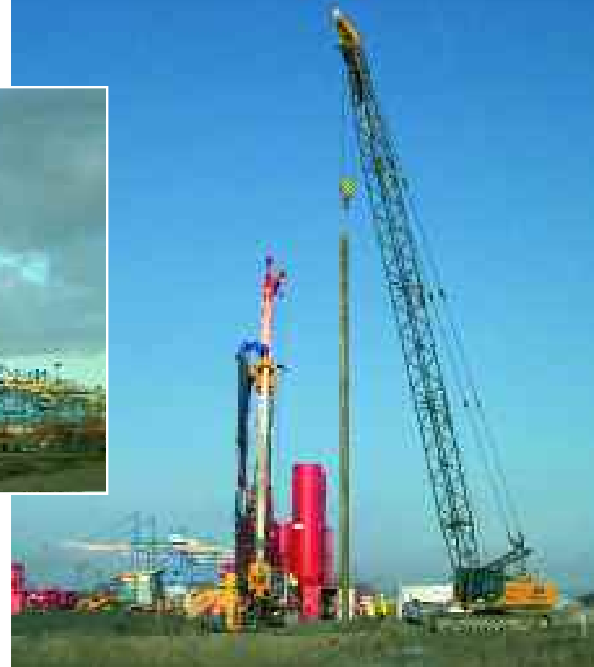
Installation d'un profilé dans la paroi CSM Installation of a profile in a CSM wall
