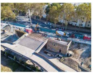
La première phase de travaux consiste à créer un soutènement provisoire dans le parc Henri Barbusse, pour dégager une plate-forme de travail en pied de talus, qui permettra de réaliser le puits en parois moulées.
