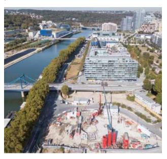
Dans un premier temps, il s'agit d'achever les quelques 200 micropieux d'ancrage du radier, scellés en arase basse. Suit actuellement la réalisation du fond injecté de 3 m d'épaisseur, à la base des alluvions anciennes, pour maîtriser les débits de pompage. Pas moins de 600 forages à 19 m devront être mis en œuvre, puis injectés au coulis bentonite-ciment et au gel mou.
