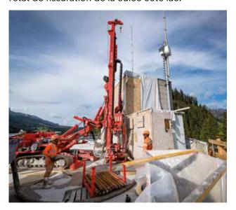
Le second objectif des travaux est de reprendre le voile d'étanchéité du barrage Nord depuis une galerie se trouvant 50 mètres sous le couronnement du barrage!
