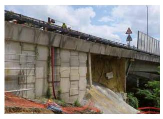
Le chantier représente un total de 250 clous de 12 m en moyenne, mis en place à l'aide d'une pelle hydraulique équipée d'une glissière de forage ou d'une petite foreuse.
