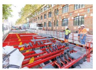
Après terrassement à l'aspiratrice-excavatrice, les réseaux sont récolés à l'avancement par un géomètre. Le plan de tir 3D est alors recalé en temps réel et les réservations de forages sont immédiatement azimutés et inclinés suivant les consignes du technicien, puis remblayées. Une fois ce travail achevé, les forages pourront débuter courant octobre.
