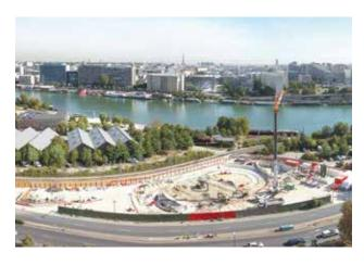
L'activité bat son plein sur le puits de lancement du tunnelier. Les parois moulées circulaires, réalisées à 55 m à l'aide de deux outillages KS, se sont achevées en juillet. La fin du chantier a été marquée par la réalisation des 4 panneaux de jonctions en Y, excavés en épaisseur 1 800 mm, équipés de cages de 80 t et représentant près de 1 200 m³ de béton chacun!
