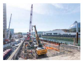
Les travaux de la gare Pont de Sèvres ont débuté à la fin du printemps par une campagne de travaux fluviaux. Ils consistent à créer une estacade sur le bras de Seine situé face à l'île Seguin.
