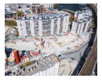
Sur la gare d'Issy, les travaux de parois moulées de la boîte gare battent leur plein. Le dernier quart de l'ouvrage est entamé, après fermeture d'une voirie et déviation d'un réseau d'assainissement. La paroi de 1,20 m d'épaisseur à 40 m de profondeur devrait s'achever fin octobre. Cette phase de travaux doit se solder dans 6 mois par l'achèvement de la dalle de couverture qui coiffe les parois et par la réouverture de la rue.
