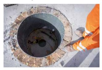
Sur la culée, les travaux ont consisté, après une campagne de reconnaissance de sol (3 sondages à 43 m), à scier la dalle non armée existante et à construire une nouvelle dalle en béton armé, bétonnée le 7 septembre dernier. Sur cette nouvelle dalle seront forés 23 tirants d'ancrages verticaux (15 torons) de 43 m de longueur, fabriqués par Freyssinet, afin d'exercer une force totale de compression de 50 000 kN sur la culée centrale.
