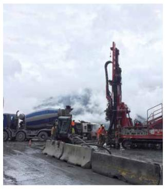
Soletanche Bachy France, en sous-traitance du groupement Razel-Bec / Implenia, intervient dans cette zone, afin de consolider le sous-sol au moyen d'injections solides. Le linéaire de la fondation de la casquette est traité entre 2 et 9 m de profondeur par des forages réalisés en Hi'Drill. Au total, environ 30 m³ de mortier seront injectés par passes remontantes de 1 m de hauteur.
